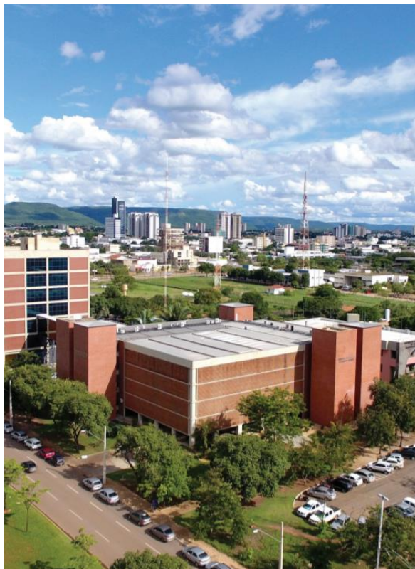
Figura 1 - PRÉDIOS SEDE DO TCETO, INSTITUTO DE CONTAS 5 DE OUTUBRO E EDIFÍCIO RUY BARBOSA
