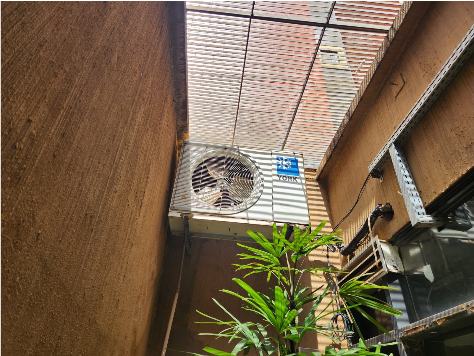
Imagem 14: Hall do Auditório.
