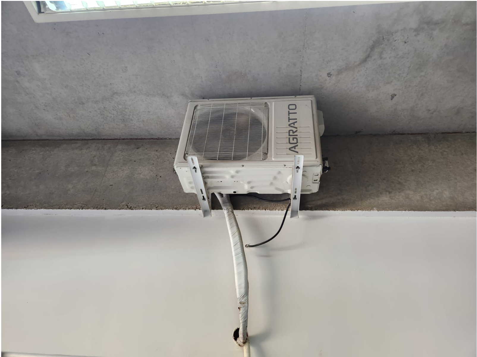
Imagem 01:Guaritas do Prédio Sede e Ruy Barbosa.
