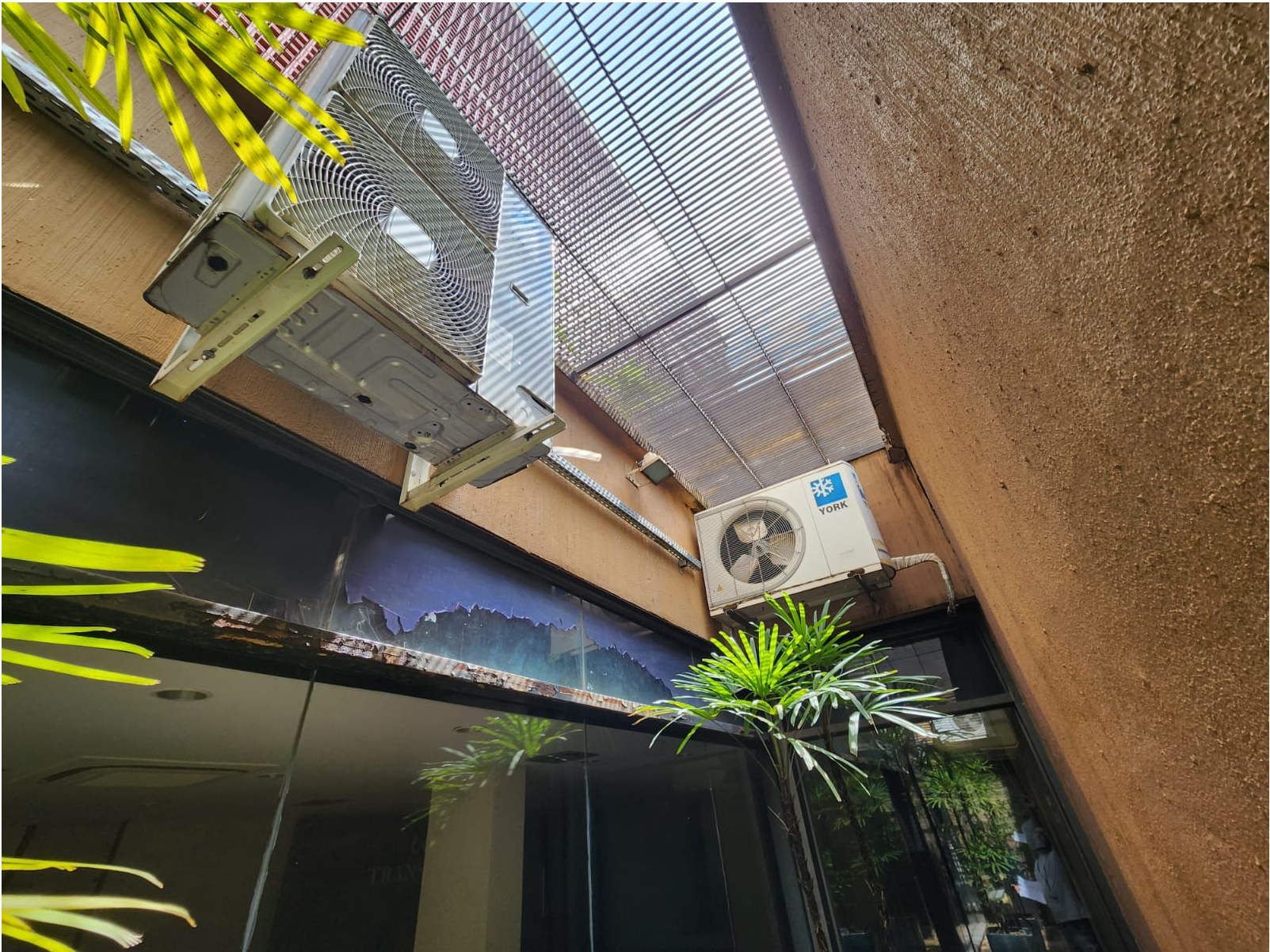
Imagem 13: Hall do Auditório.
