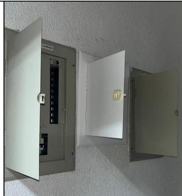
Quadros de destruição elétrica sem dispositivo de proteção contra surto (DPS).
