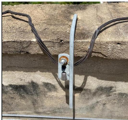
Em desconformidade com a NBR5419, pois a cordoalha de cobre nú não está conectada no captor e não está esticada na platibanda.
