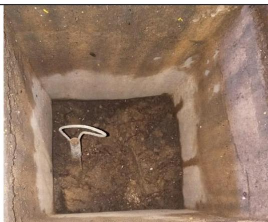
Caixa de inspeção de aterramento localizado no subsolo da edificação está fora de norma, não foi identificado haste de aterramento.
